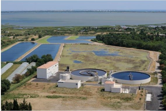
la station d'épuration de Mauguio-Mudaison
