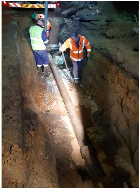
Casse 2 : Allée des bergeronnettes. Remise en eau à 3h30. Remblaiement dès le lendemain
