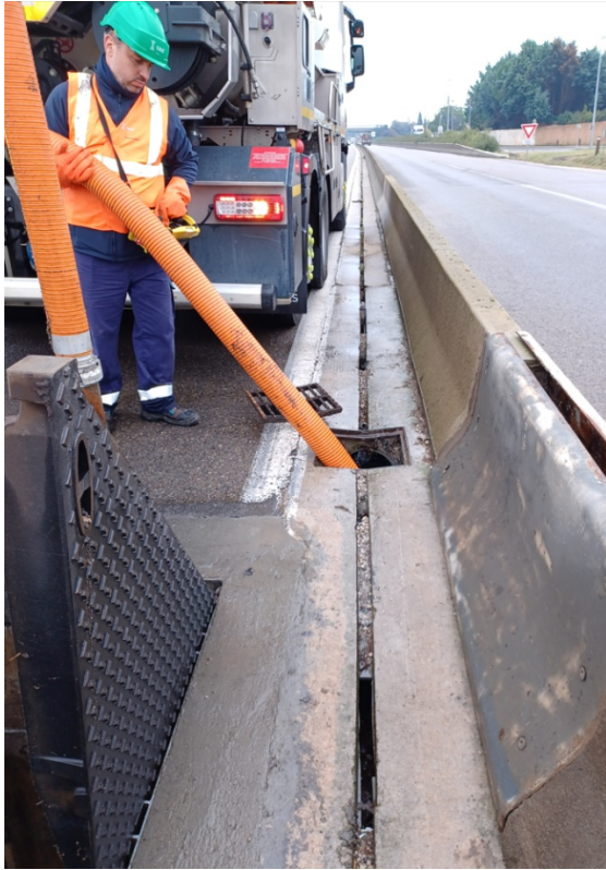
Sur la quatre voies RD66, pompage de la chambre :
