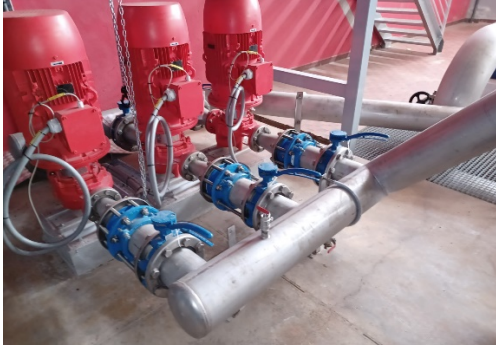
Pompes de prélèvement vers analyseur de chlore
