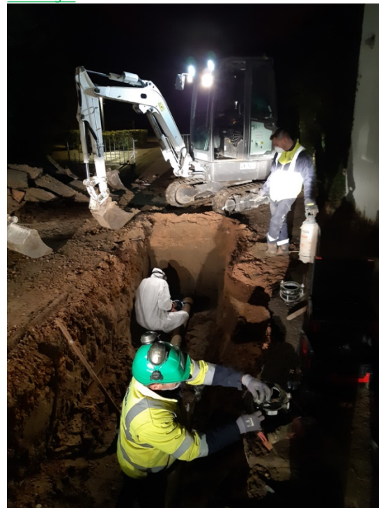
Casse 3 : placette des Fauvettes. Remise en eau à 1h. Remblaiement le lundi suivant après concertation avec le voisinage.
