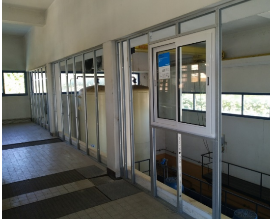
Montage de la cloison, avec deux fenêtres :
