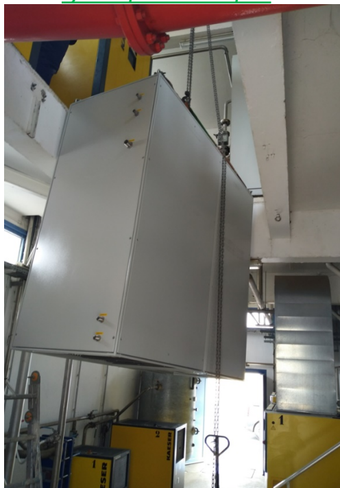
Montage de l'armoire d'ozonation provisoire (prêt société O.E.I.), connexions hydrauliques et électriques:
