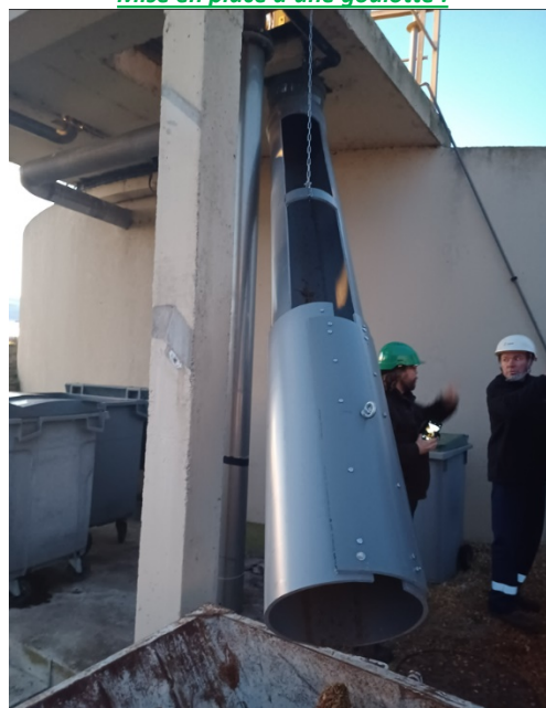
Mise en place d'une goulotte :
