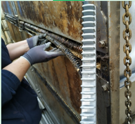
Mise en place d'écarteurs neufs dans les modules rechapés :
