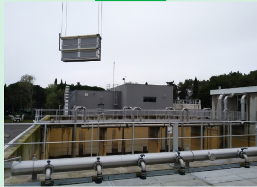
Grutage module par module puis connexions hydrauliques :
