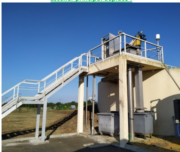
Escalier principal déplacé :
