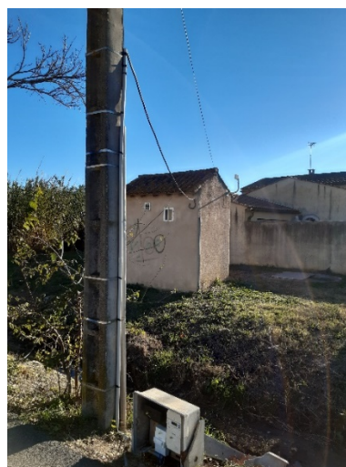
Alimentation provisoire aérienne du poste de relevage principal, et du coffret Enedis à déplacer :
