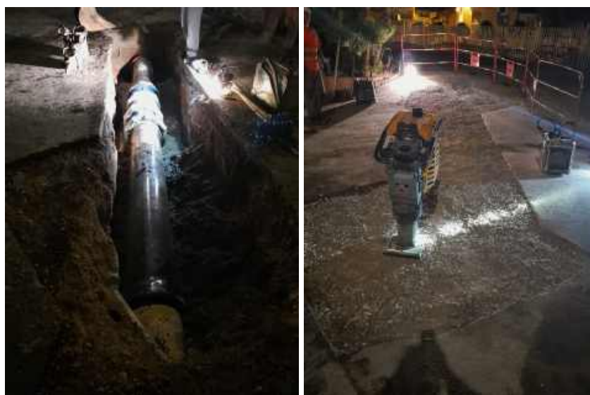
Pose d'une nouvelle conduite sur une longueur de 6 ml
