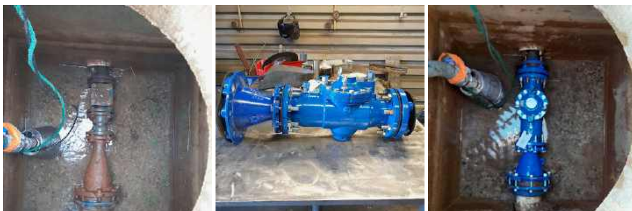
05 Décembre - Renouvellement du disconnecteur sortie compteur eau potable
