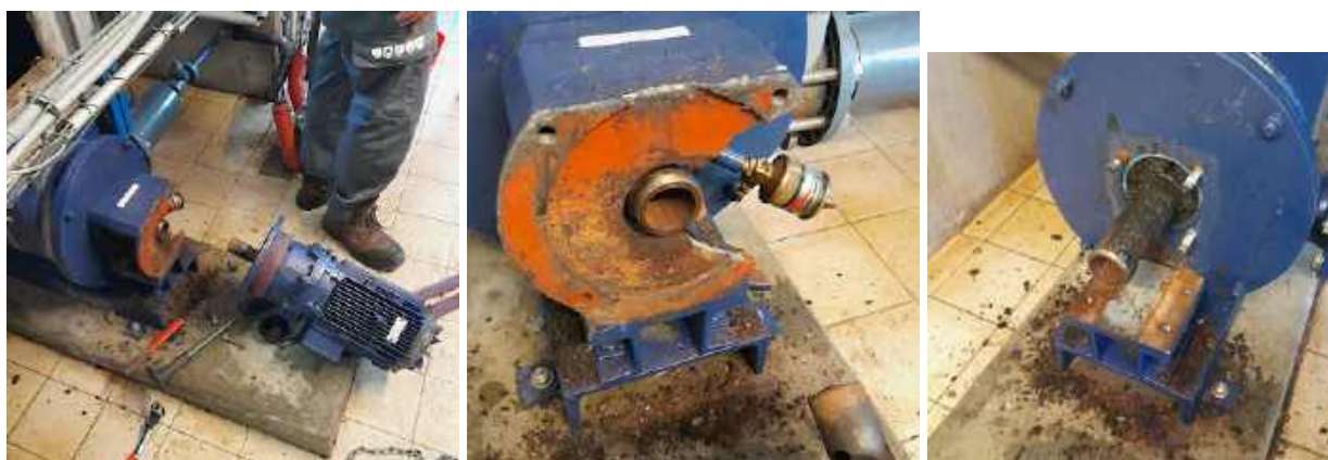
16 août - Changement d'un moteur sur l'agitateur ZC
