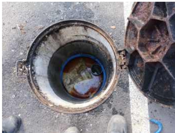
Constataion de graisses figées avant le rejet
