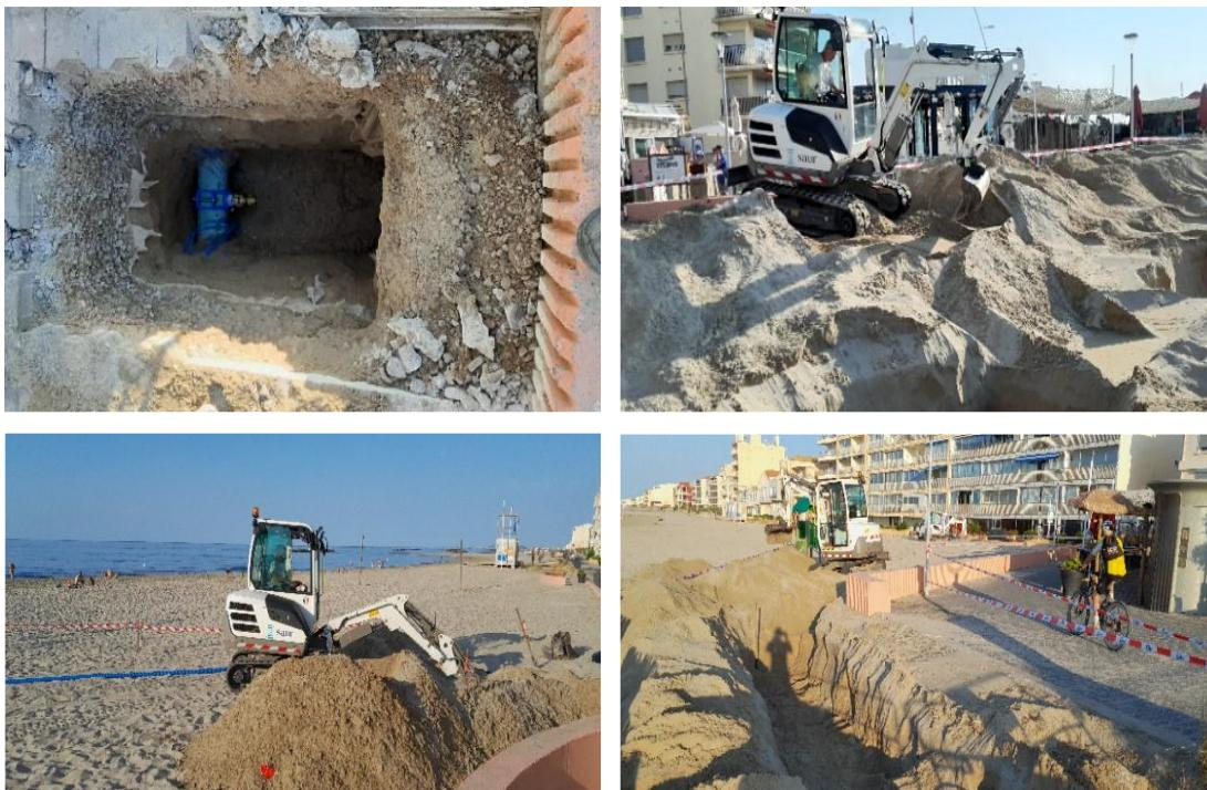
► 09/09/2024, Renouvellement Vanne DN80 en amont du compteur du Splash. Fuite sur la vanne de 50m3/j
