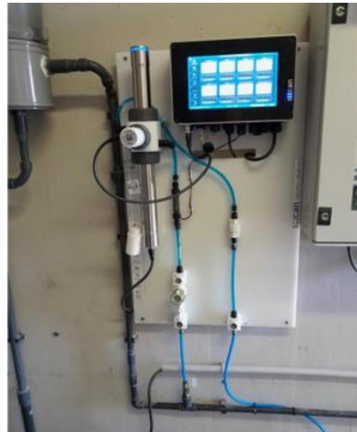
Analyse spectrale en sortie de CAG, avant stockage :
