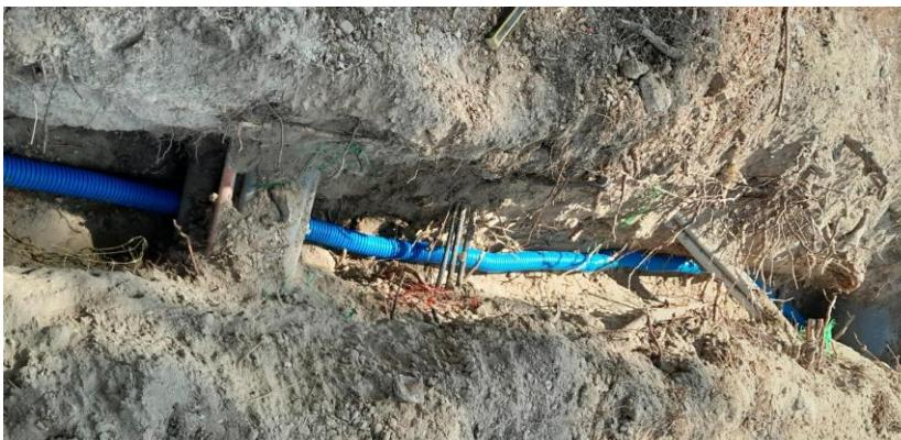
► 21/08/2024 : Casse branchement AEP au n°11 Rue du Levant par un sous-traitant TP de VEOLIA lors d'un chantier assainissement
