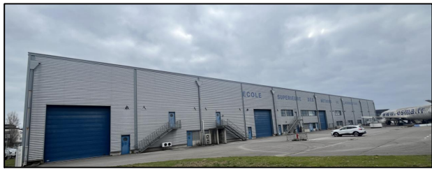
FACADE OUEST DU BATIMENT HANGAR
